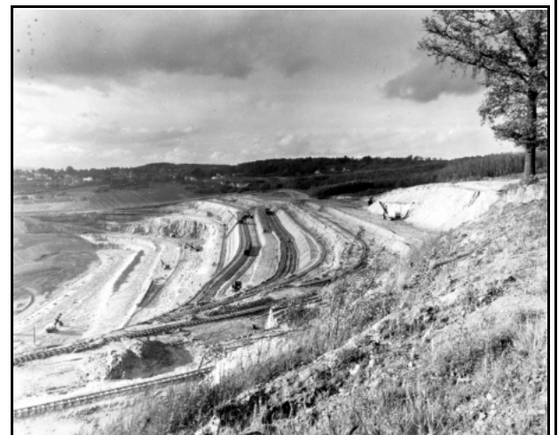
La carrière Lambert dans les années 1950. La mécanisation a accéléré l'exploitation. On distingue les banquettes créées par couches géologiques successives. Sur celles-ci des Decauville, chemins de fer de carrière, sillonnent les différents fronts de taille. Coll. Musée du Plâtre.
