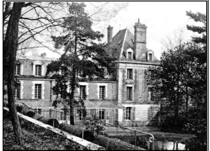
Maison de Pierre Cottin, rue Neuve à Cormeilles, à laquelle était attenante l'exploitation agricole dont les Lambert furent fermiers. Avant la Révolution, il s'agissait de la propriété de Courtin de Crouy. Appelé « Le Petit Château » au XX e siècle, c'est aujourd'hui le LEP Le Corbusier, 30 rue Jean Jaurès. Carte postale vers 1910, coll. Musée du Plâtre.
