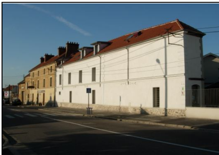
La ferme Lambert du « Petit-Cormeilles ». A gauche la partie la plus ancienne, à droite les extensions de la ferme. (Photo : V. Farion, 2007)
