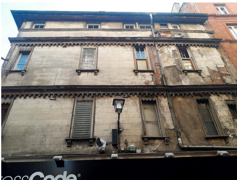
Toulouse (Haute-Garonne) Façade en stuc pierre de plâtre blanc du 41 rue des Changes.
