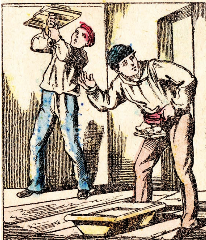
► Plâtriers au travail, détail de planche, Imagerie d'Épinal Pèlerin, XIX e siècle. Coll. Musée du Plâtre.
