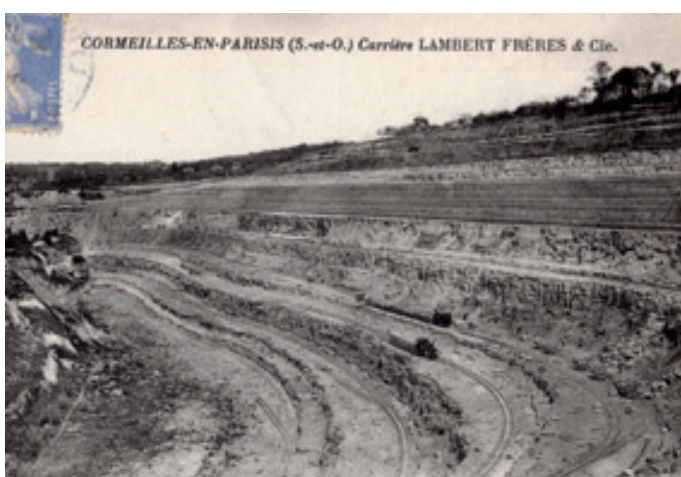
► Carrière Lambert de Cormeilles, carte postale, années 1920. Coll. Musée du Plâtre. « Cette carrière s'étale au flanc d'une haute colline, qui est attaquée de la base au falte par une large entaille de 500 mètres d'ouverture et d'une hauteur de 75 mètres environ. Elle est coupée en gradins et exploitées par étage desservies par plus de 10 kilomètres de voies Decauville, au moyen de pelles mécaniques, locomotives et wagonnets qui emportent sans arrêt les matières premières aux diverses parties de l'usine ». Extrait de La Céramique , n° 439, septembre 1924.
