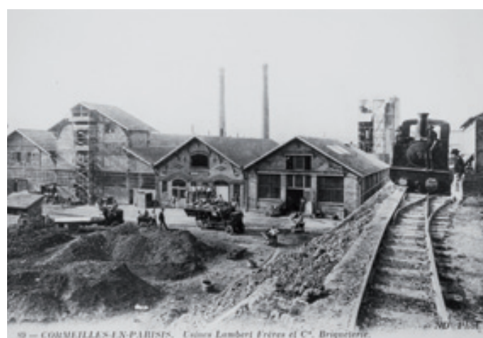
► La briqueterie Lambert à Cormeilles, carte postale, années 1920. Coll. Musée du Plâtre. « [La briqueterie] comprend deux groupes de fabrication, (...) des séchoirs à tunnels et à chambres, trois fours à feu continu. (...) La cuisson s'y effectue à une température de 1 000 à 1 100° (...) La production journalière est d'environ 100 tonnes. Elle se compose de produits de différents modèles : briques creuses de tous formats, briques pleines ordinaires, briques de parement rouges et blanches, poteries (boisseaux, wagons, ventouses) et de mitrons des modèles courants ». Extrait de La Céramique , n° 439, septembre 1924.
