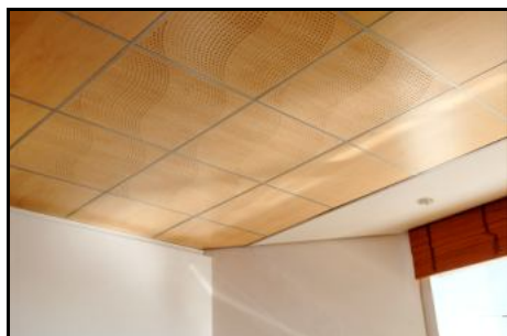
Plafond en dalles plâtre, aspect bois.
