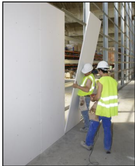
Mise en place de plaques de grande taille.
