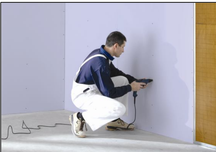
Pose d'une plaque de plâtre phonique en doublage.
