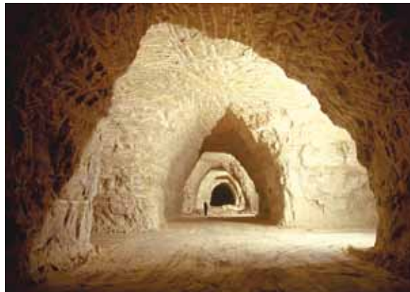
▲ Carrière souterraine de Montmorency, vue générale d'une galerie creusée dans le cœur du gypse. Après exploitation et avant remblayage.
