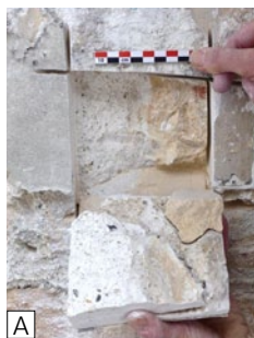
Echantillon d'enduit du Théâtre de la Renaissance. A : prélèvement sur site. B : Observation des couches à la loupe binoculaire.
